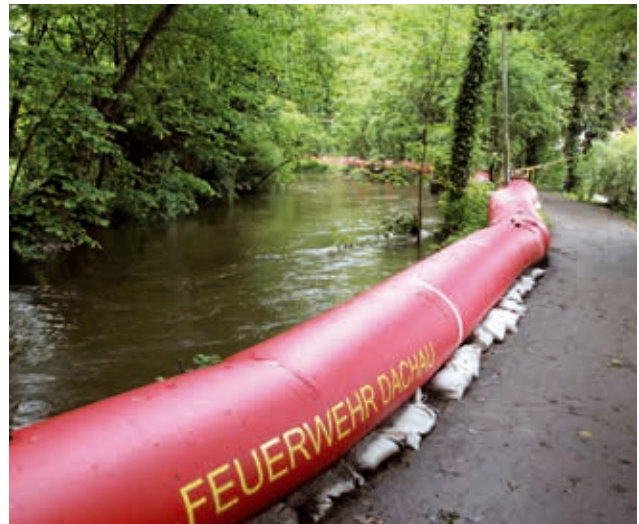
Gefahrenstelle entschärft: Am Gröbenbach wurde ein 200 Meter langer Damm errichtet.
