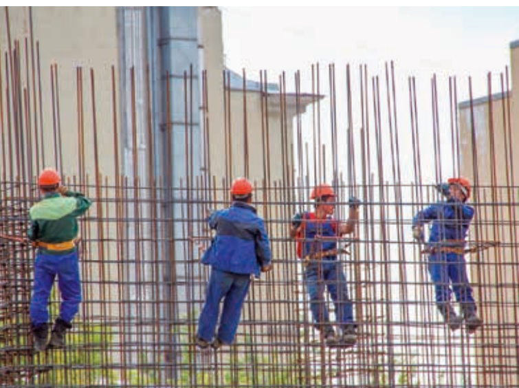
Den Traum von einer eigenen Wohnung verwirklichen: dazu tragen künftig die Grundsätze der Baulandentwicklung sowie das Dachauer Modell zur Wohnraumförderung bei.
