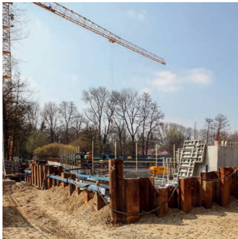
Deutliche Fortschritte gibt es nun beim Bau des neuen Hallenbads (unser Bild stammt von Anfang April) – die Fertigstellung ist für Herbst 2020 geplant.
