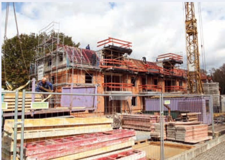
Das neueste Bauprojekt der Stadtbau in Dachau-Süd schreitet zügig voran.
