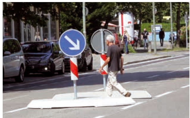
Querungshilfen in der Straßenmitte sichern Fußgänger und Radfahrer beim Überqueren der Straße.
