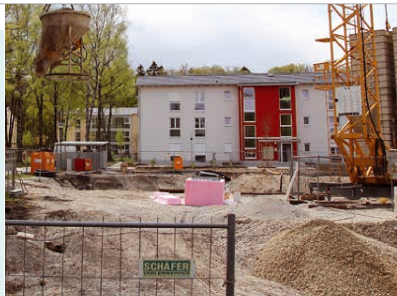
Am Rennplatz in Dachau-Süd entstehen zwölf weitere Wohnungen für Familien.
