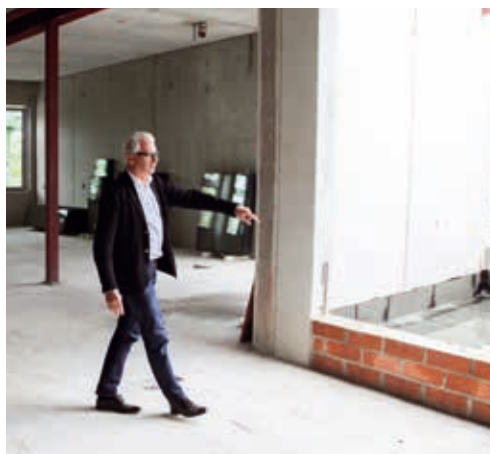
Da müssen wir noch was machen: Architekt Ferdinand Krissmayr führt im Juni durch die Baustelle der Mittelschule Süd. Bis September 2019 soll sie fertig sein.
